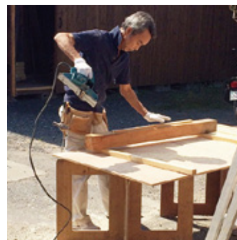
各種木工事 造作家具、造作家具、床工事
