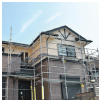
各種外部工事 外壁、屋根、剪定、伐採、解体工事
